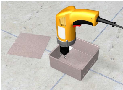
Blechgehäuse auf Rohdecke befestigen
